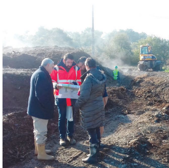
Réunion de chantier dans le cadre des travaux au Centre d'Apport Volontaire de Porcaro.
